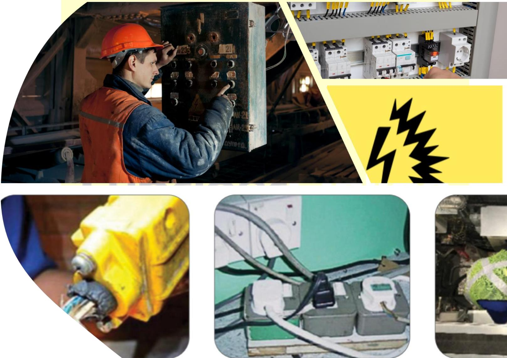
**Figura 1: Peligros eléctricos: Cables o terminaciones dañados/expuestos, Equipo eléctrico defectuoso, Circuitos y enchufes sobrecargados**
