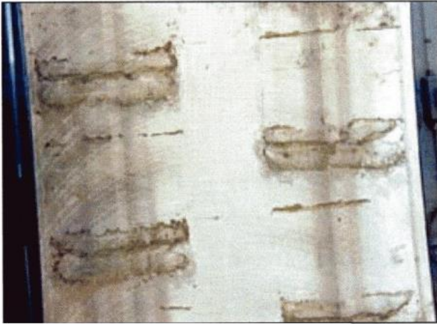
Fig. Manchas de grabado en equipo almacenado.
